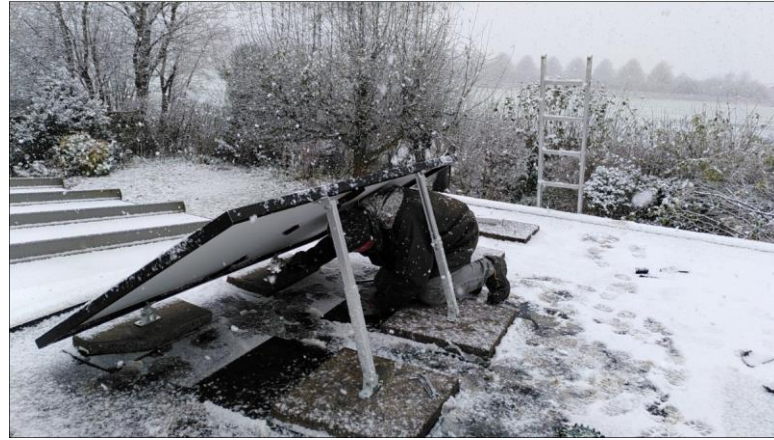
Installation auf Flachdach
